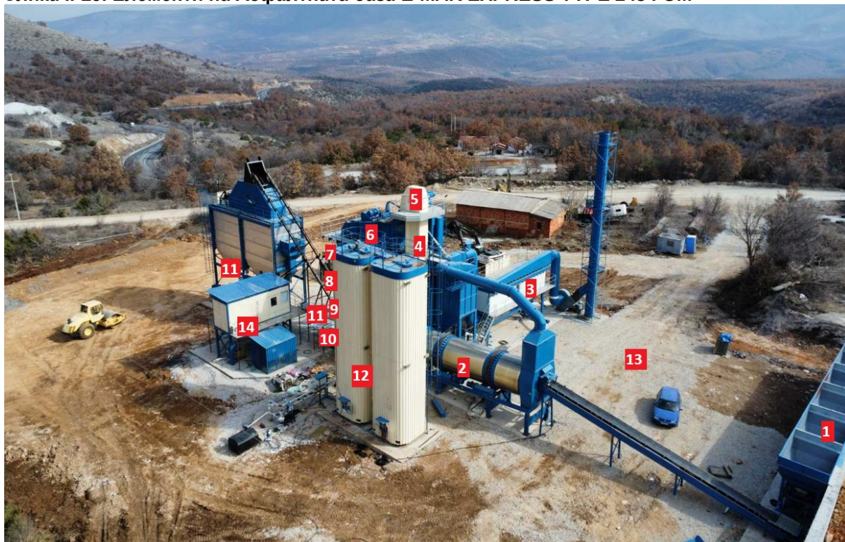
Слика II-29. Елементи на Асфалтната база Е-МАК EXPRESS TYPE 245 FUM
