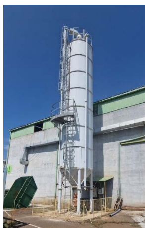
Слика 22 Изглед на силос
