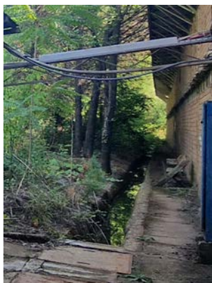
Слика 12 Бетонски канали за собирање на атмосферските води
