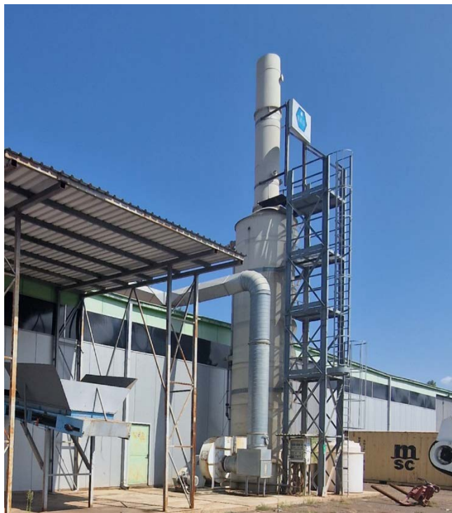
Слика 22 Скрубер за третман на гасовите од технолошката линија PHARAON 300
