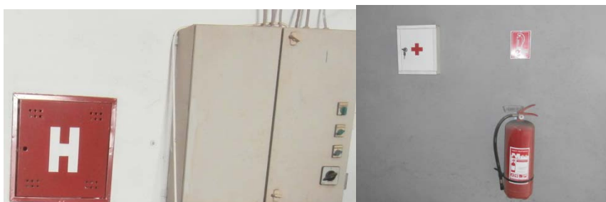
Слика 86 Поставена хидрантска мрежа и ПП апарат на Инсталацијата
