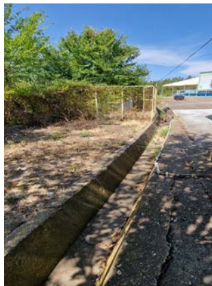
Слика 12 Бетонски канали за собирање на атмосферските води
