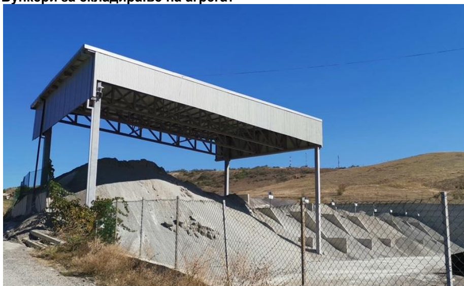
Слика II-4. Бункери за складирање на агрегат
