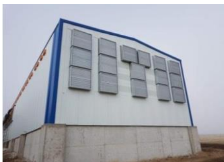
Слика 42 Странични фен вентилатори за испуст на воздух
