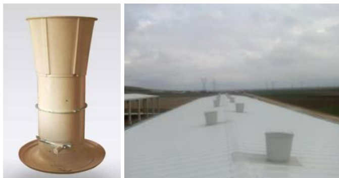
Слика 43 Кровни оџаци на системот за вентилација
