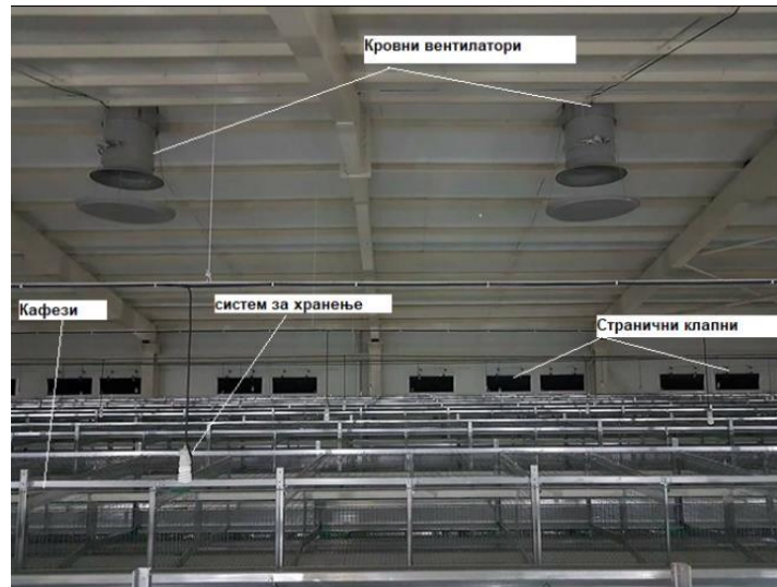
Слика 31 Поставеност на вентилатори во однос на кафезниот систем во едно од одгледувалиштата за кокошки несилки
