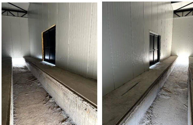
Слика 40 Внатрешни бетонски канали во одгледувалиштата
