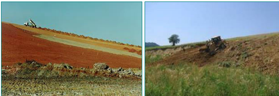
Слики Прилог 3-7,8: Подготовка на почвата за санација на пределот
