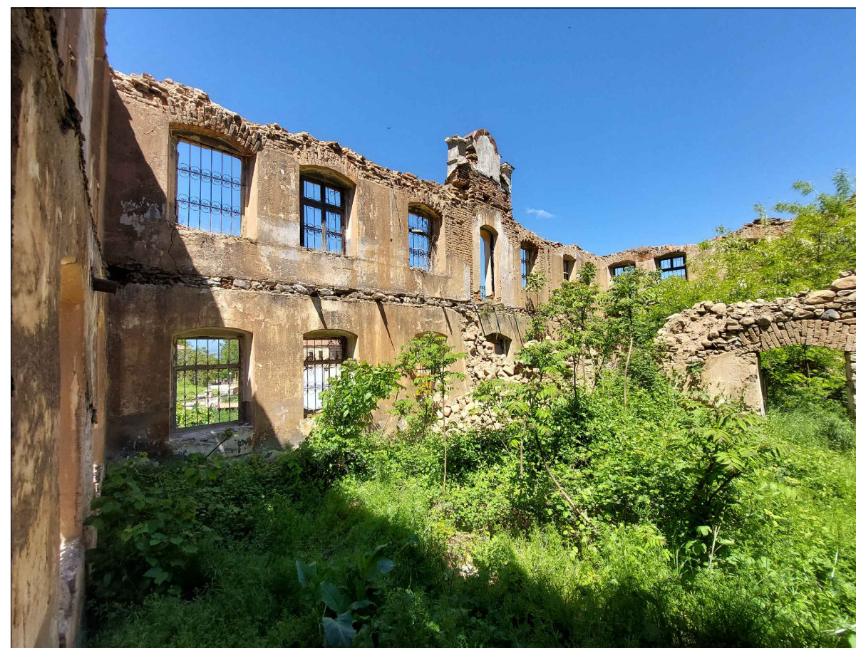
ВНАТРЕШНОСТ НА ОБЈЕКТОТ - ПОСТОЕЧКА СОСТОЈБА -
